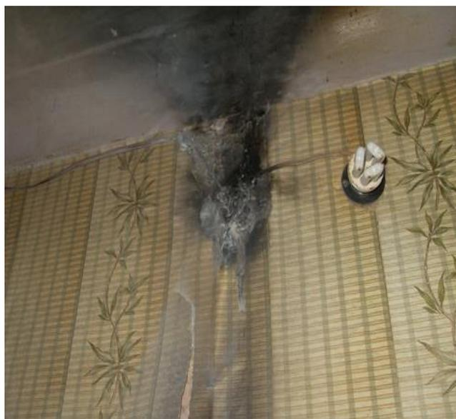
Небезгрешны и распаечные коробки, так как раньше провода порой просто скручивались пассатижами и обматывались добротной изоляцией, всё бы ничего, да вот после нескольких волн косметических ремонтов хозяева вряд ли добивались до проводки и как следует, осматривали её на наличие перегрева. Но при этом абсолютно каждый из нас твёрдо знает: плохая проводка причина хорошего пожара.
